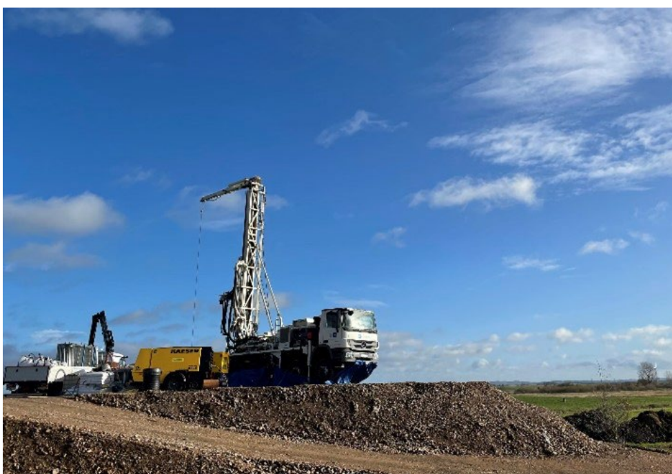
Figur 8. Brunnborrning vid Grevie vattentäkt. Bild: VA Syd.
