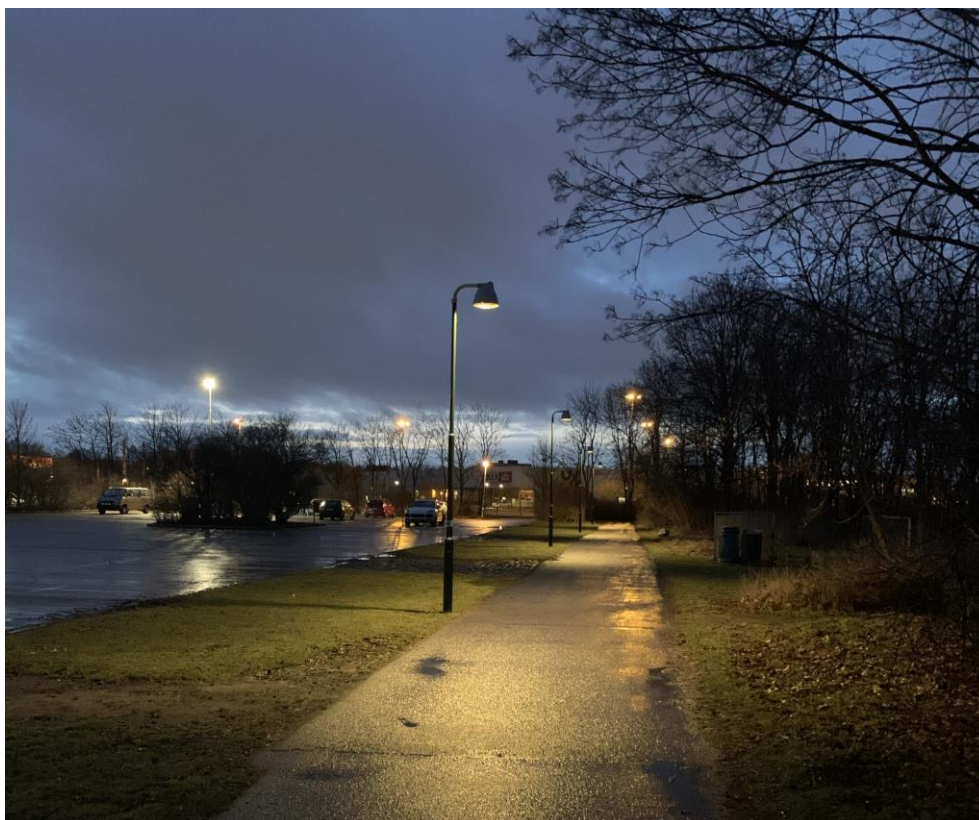
Figur 4. Utbyta armaturer för belysning av cykelväg i Bulltofta. Bild Malmö stad.
