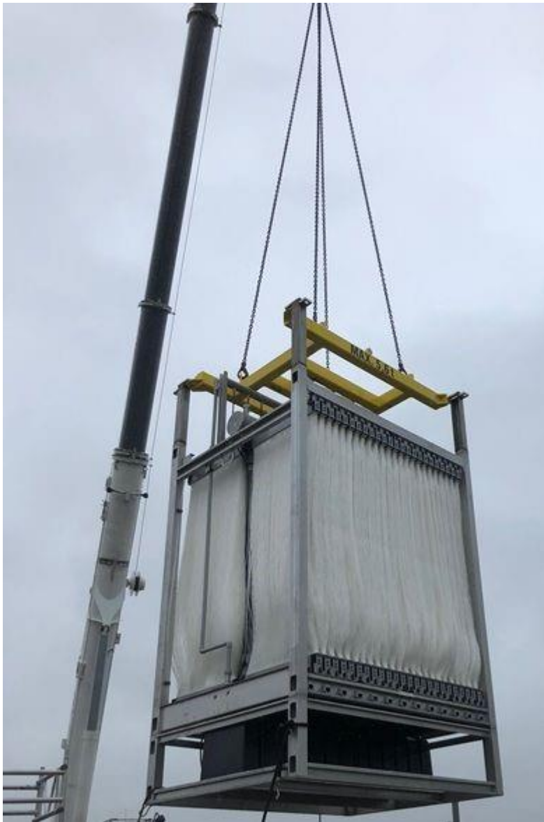
Figur 6. Kassetter med hålfibermembran för biologisk behandling av avloppsvatten genom biofilmsteknik. Bild VA SYD.
