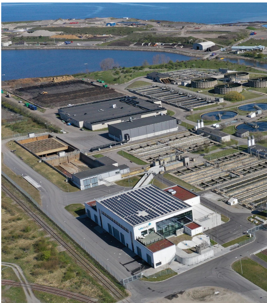
Den nya energieffektiva byggnaden med solceller på Sjölanda avloppsreningsverk, syns i förgrunden. Bild VA Syd.
